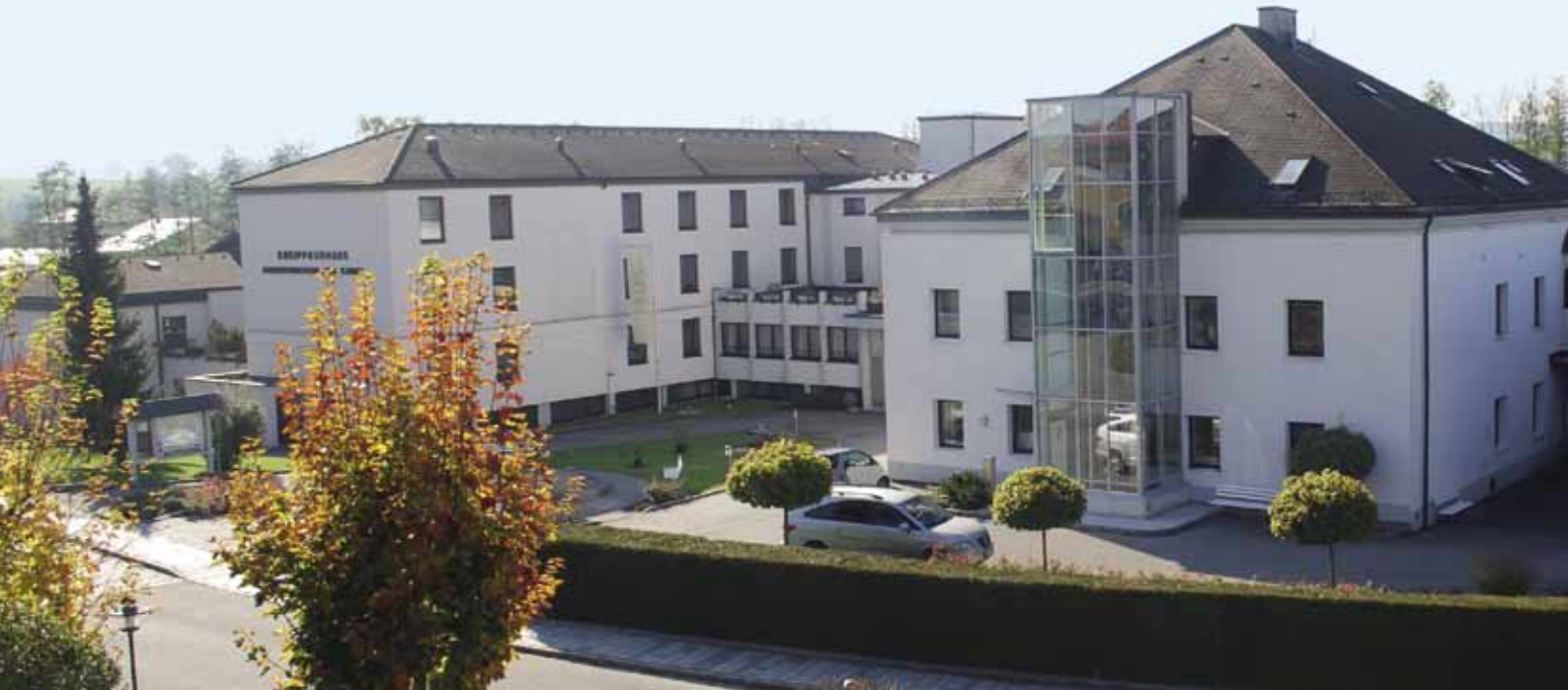
Neufärbelung Objekt „Marktplatz 6“
