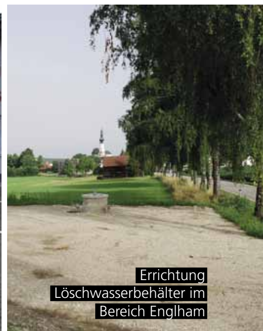
Errichtung Löschwasserbehälter und Sickerbecken Wasserdobl
